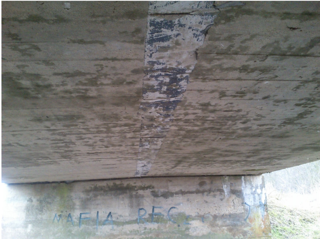
Fotografia nr 23 - Widok na spód płyty pomostu. Cz. 1
