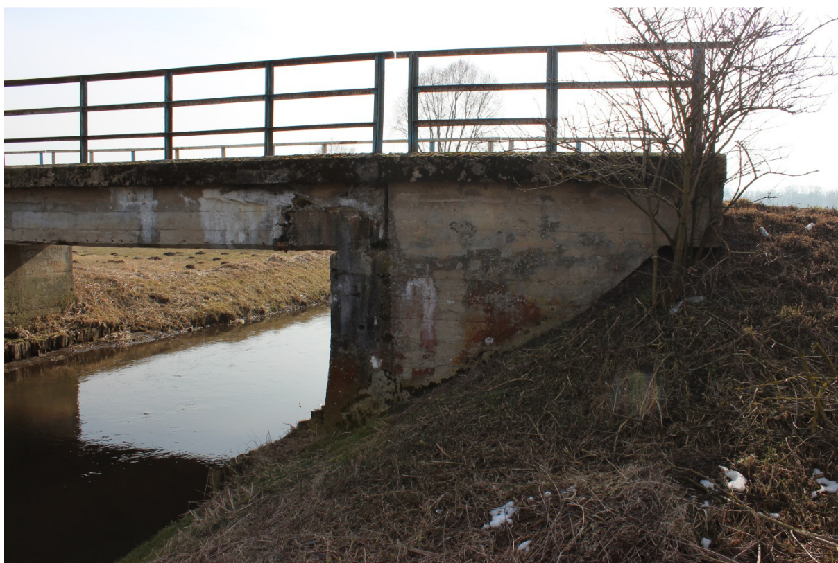
Fotografia nr 11 - Widok od strony północnej. Cz. 1
