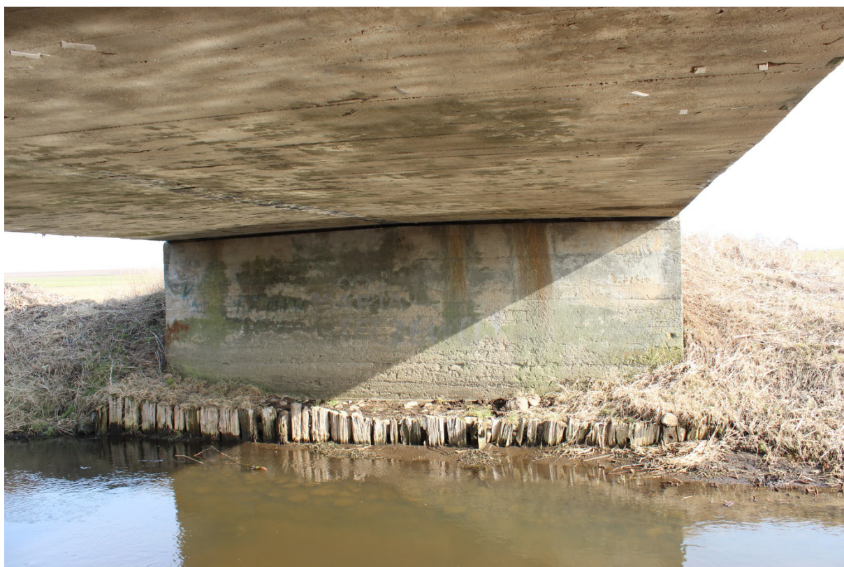
Fotografia nr 21 - Widok pod płytą pomostu na przyczółek wschodni
