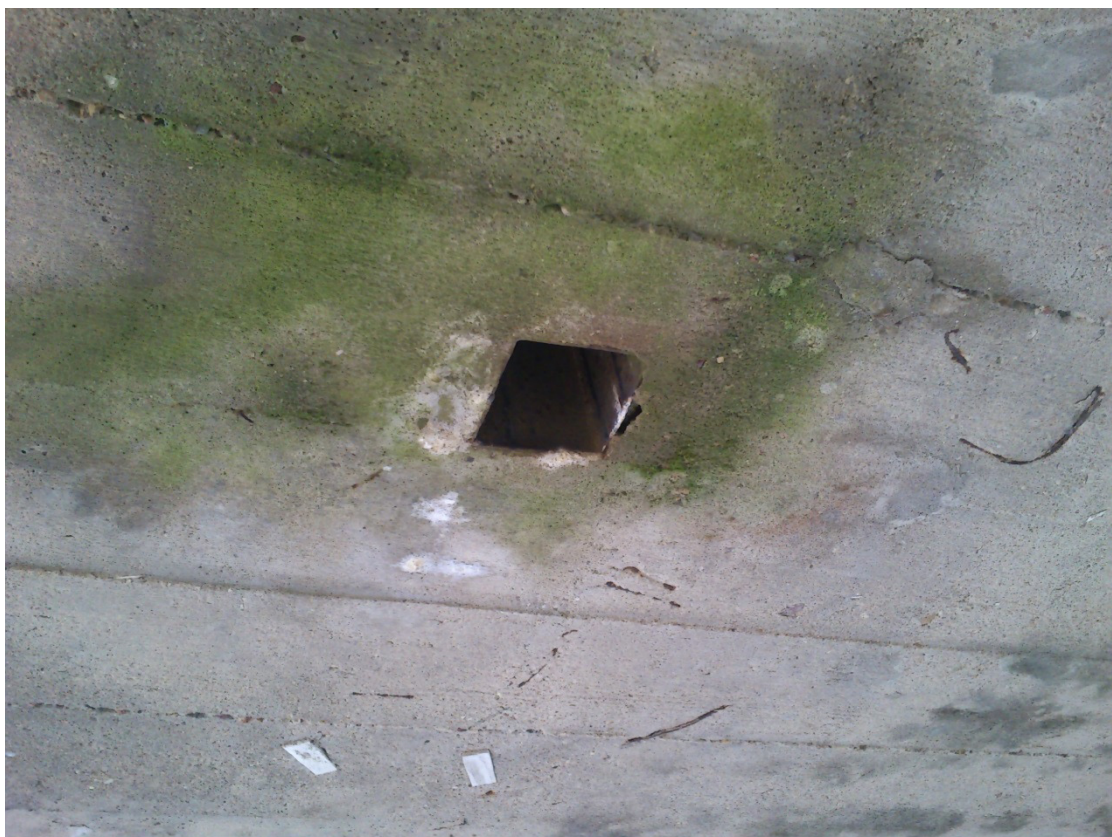
Fotografia nr 26 - Widok na spód płyty pomostu, istniejące odwodnienie. Cz. 3
