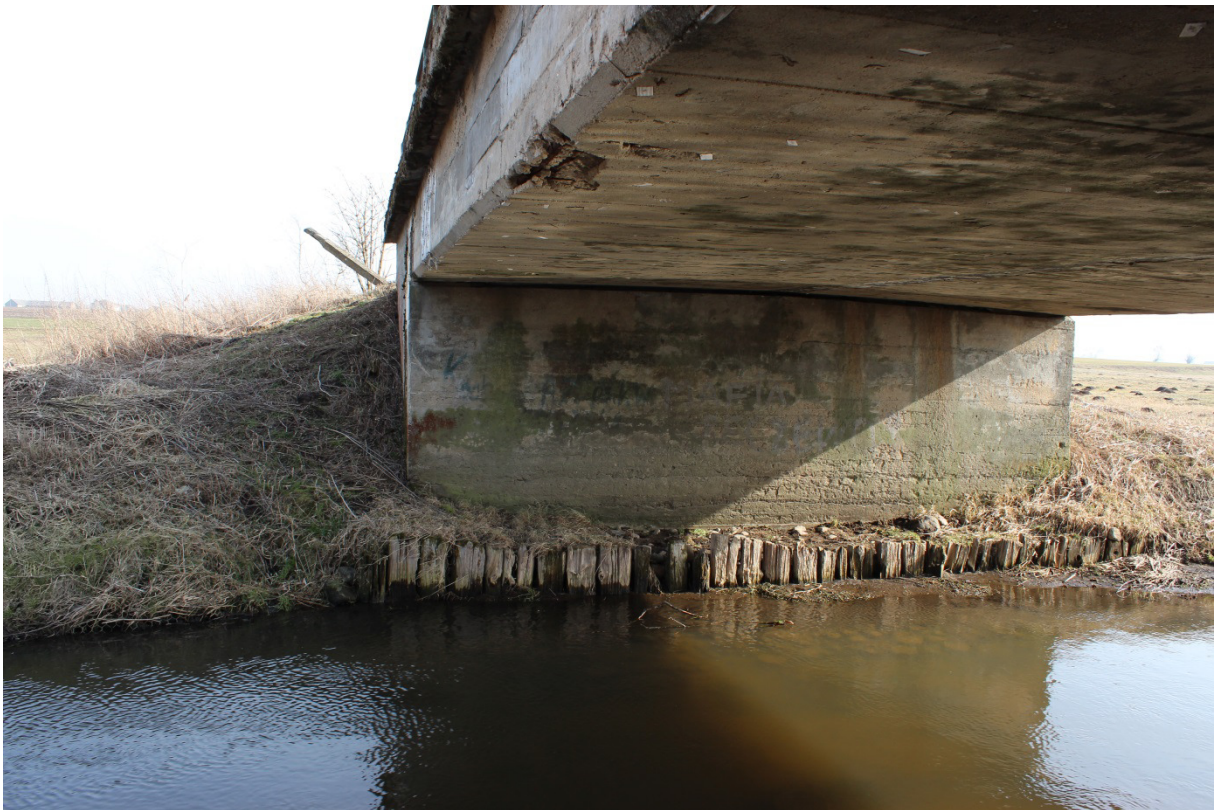
Fotografia nr 15 - Widok od strony północnej. Cz. 5
