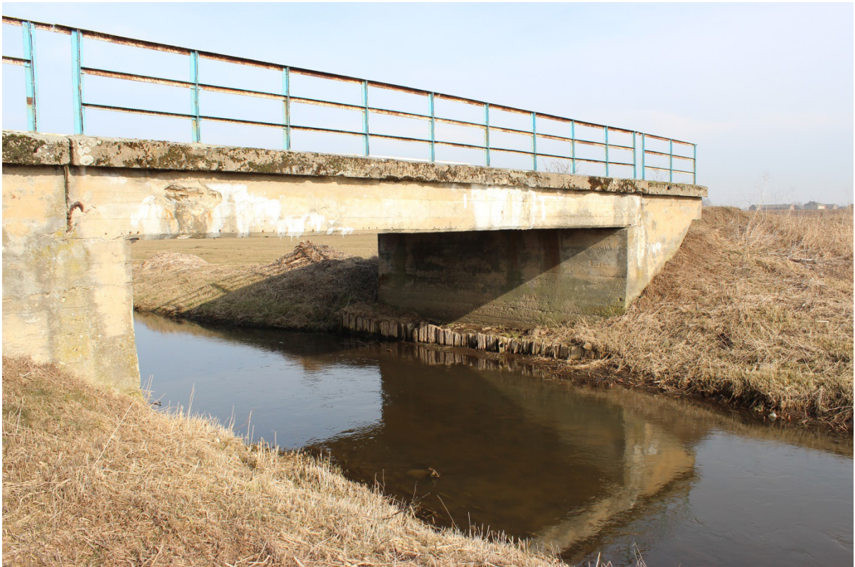
Fotografia nr 2 - Widok od strony południowej. Cz. 2
