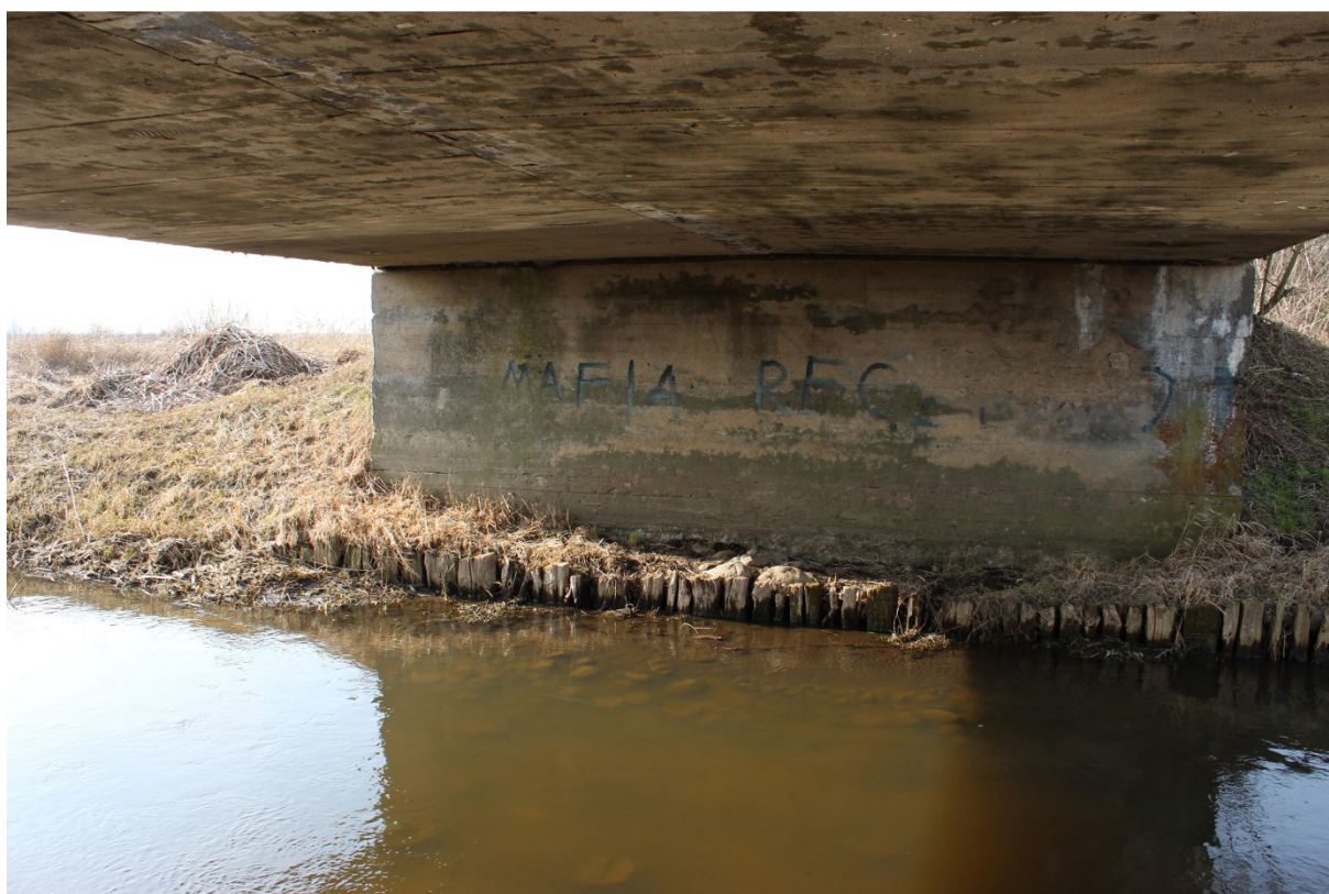
Fotografia nr 22 - Widok pod płytą pomostu na przyczółek zachodni
