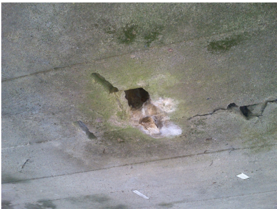
Fotografia nr 25 - Widok na spód płyty pomostu, istniejące odwodnienie. Cz. 2
