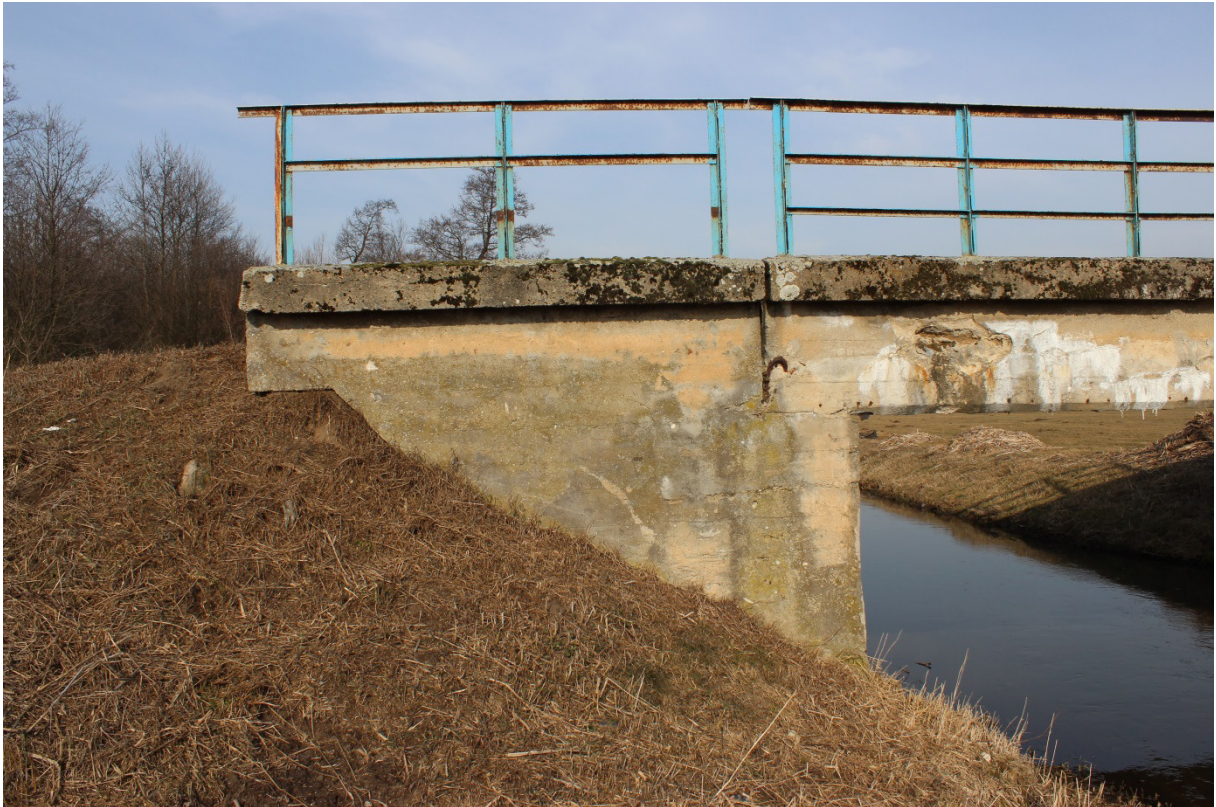
Fotografia nr 1 - Widok od strony południowej. Cz. 1
