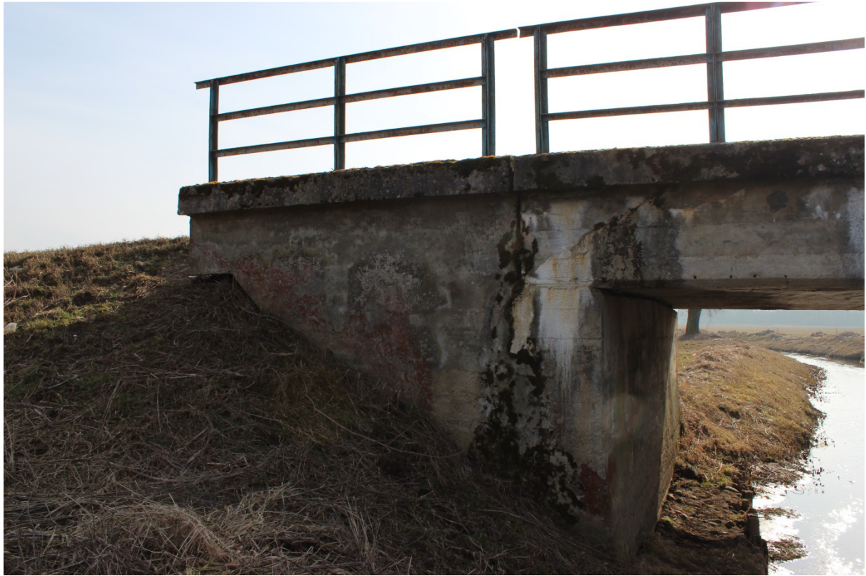
Fotografia nr 16 - Widok od strony północnej. Cz. 6
