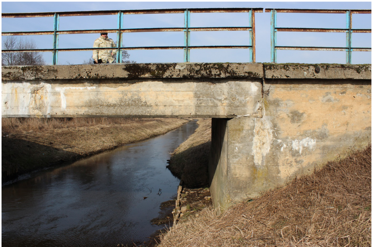
Fotografia nr 4 - Widok od strony południowej. Cz. 4
