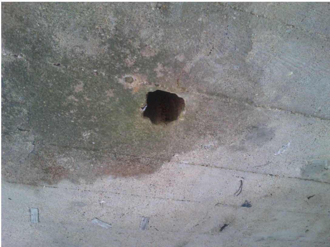
Fotografia nr 24 - Widok na spód płyty pomostu, istniejące odwodnienie. Cz. 1
