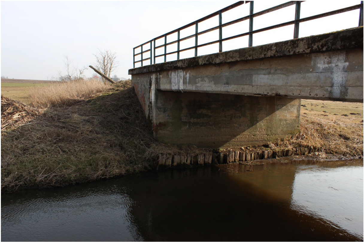
Fotografia nr 14 - Widok od strony północnej. Cz. 4
