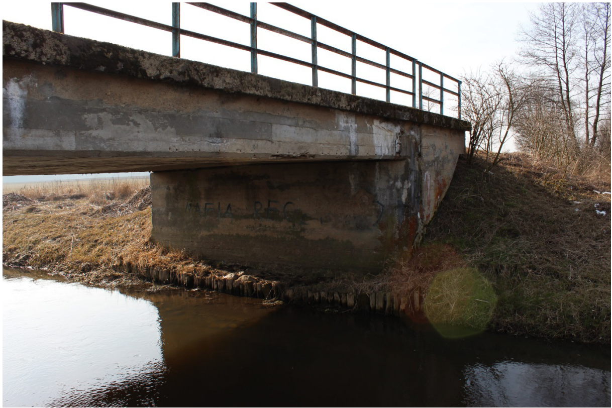
Fotografia nr 12 - Widok od strony północnej. Cz. 2
