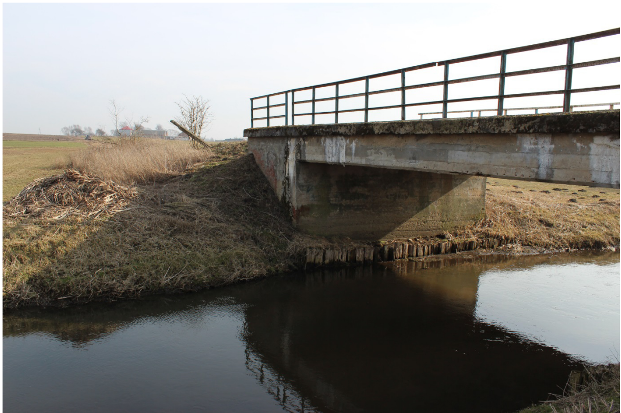
Fotografia nr 13 - Widok od strony północnej. Cz. 3
