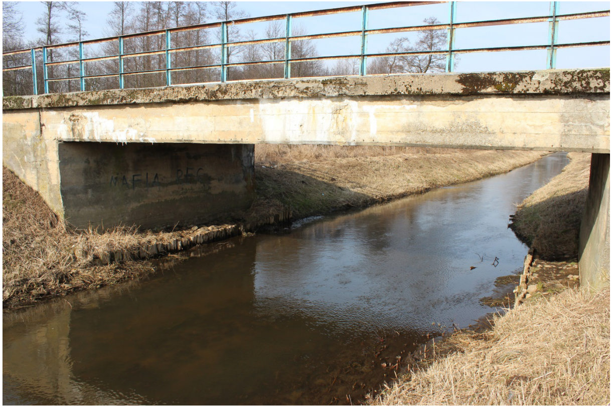
Fotografia nr 3 - Widok od strony południowej. Cz. 3
