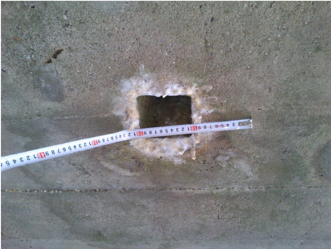
Fotografia nr 28 - Widok na spód płyty pomostu, istniejące odwodnienie. Cz. 4
