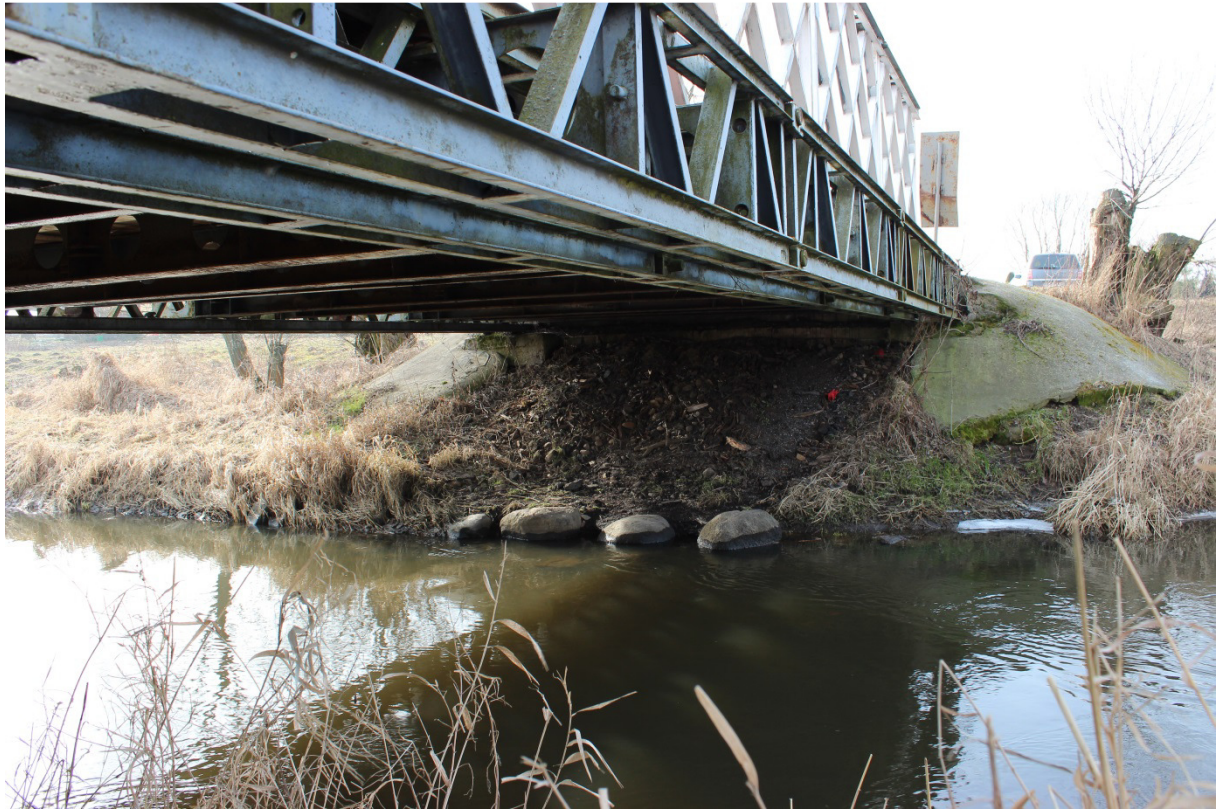
Fotografia nr 7 - Widok od strony północnej - na lewy brzeg
