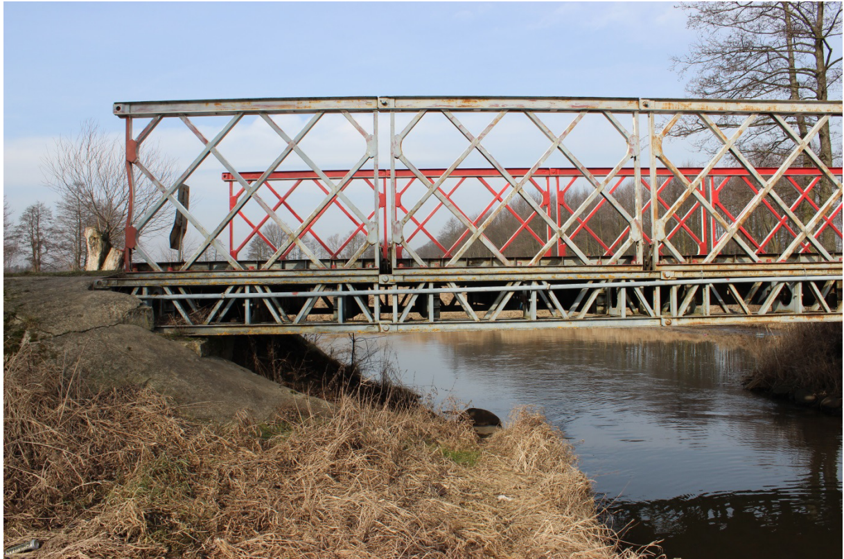
Fotografia nr 1 - Widok od strony południowej - na lewy brzeg
