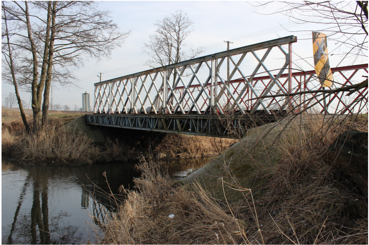
Fotografia nr 5 - Widok od strony północnej - na lewy brzeg
