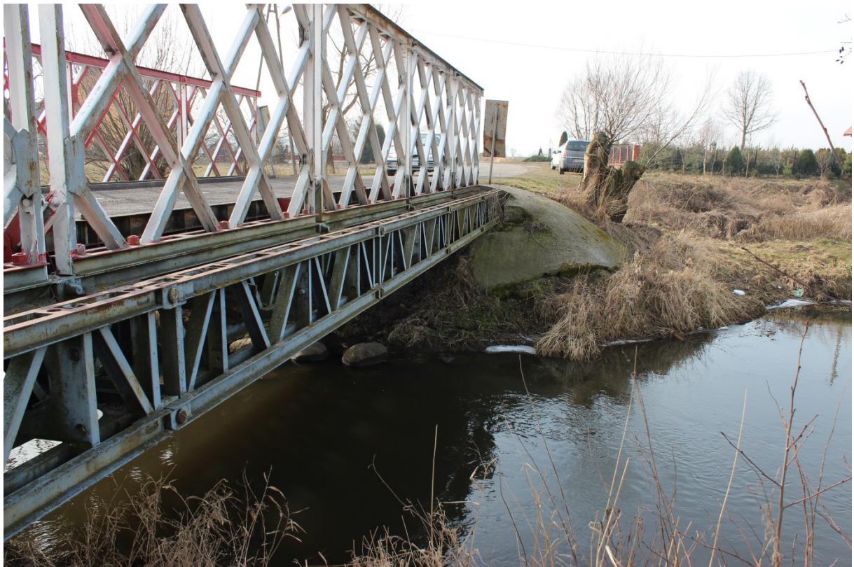
Fotografia nr 6 - Widok od strony północnej - na lewy brzeg
